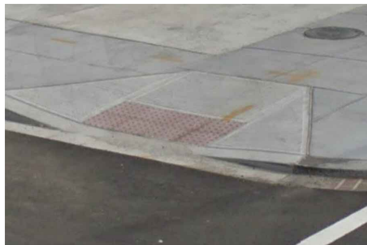
6 EXISTING ADA RAMP
